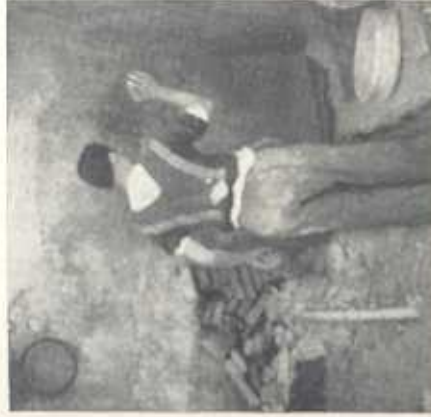
Fig. 1. Acto de atirar com o barro à parede. À direita: barreira e crivos de passar o barro.
