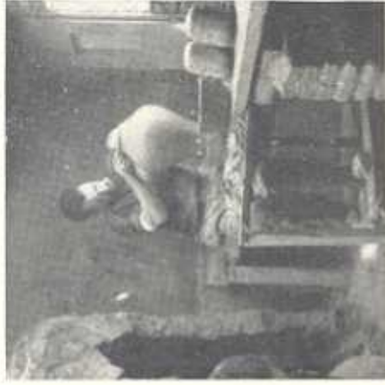
Fig. 2. Modelação na roda. À esquerda: Chaminé destinada ao fogo, durante o inverno, para manter a pasta em boa seião. À direita: Aroquina, sobre a qual se vê o barranhão e duas pélias destinadas à modelação de dois potes.
